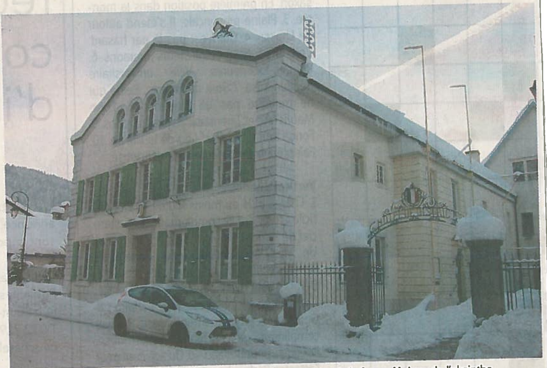
Des gabarits sur l'ancien tribunal de Môtiers indiquent les contours de la future Maison de l'absinthe.
